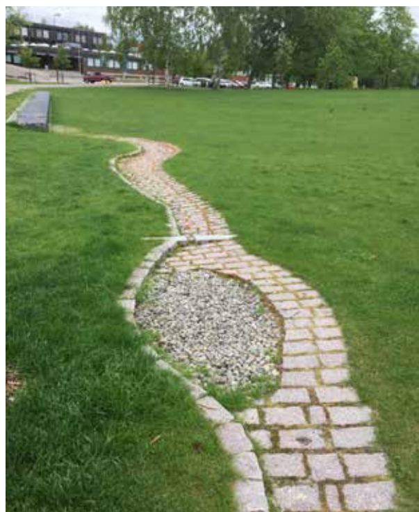
R3 Käyttöviheralue, imeytyskaivanto, Kirjastopuisto, Vantaa.
