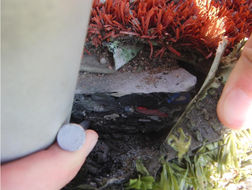
Kuva 5. Erään keinun putoamisalustarakenne (hiekkatekonurmi + joustokerros).
