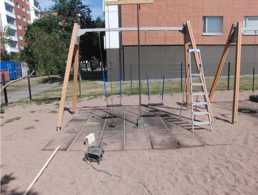
Kuva 14. Kumilaatan sauman aukeaminen ja ympäröivän hiekan kulkeutuminen putoamisalustalle.
