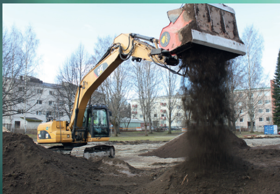
Rakennuspaikalla syntyvistä pintamaista voi tehdä kasvualustaa ja muista rakennusmaista voi muotoilla korkeuseroja.
