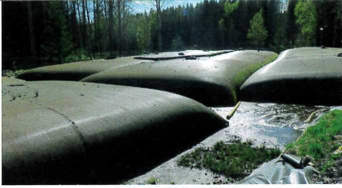
Lietemassat ovat kuivuneet geotuubeissa vajaan vuoden.
