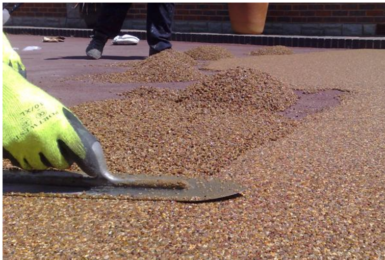
Kuva 16. Kulutuskerroksen viimeistelyä (Resin bonded n.d.).
