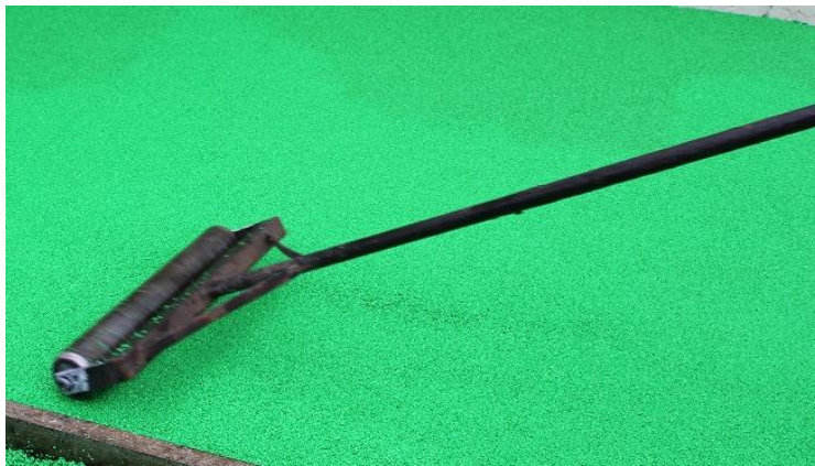
Kuva 10. Kulutuskerroksen pinnan jyräys (The rubber company n.d.).
