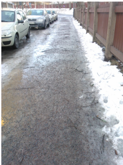
Kuva 16. Sulamisvesi kastelee ja liukastuttaa jalkakäytävän.
