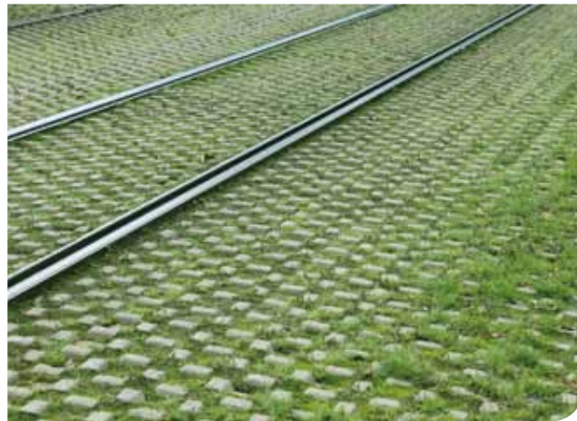
Kiveykset voidaan tehdä vettä läpäisevillä materiaaleilla.
